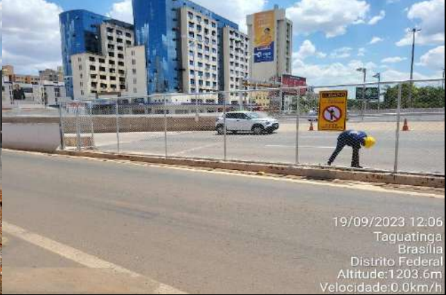
Serviço: Alambrado Finalizado Local: Taguatinga
