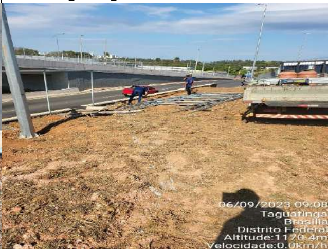
Serviço: Instalação de Alambrado Local: Taguatinga
