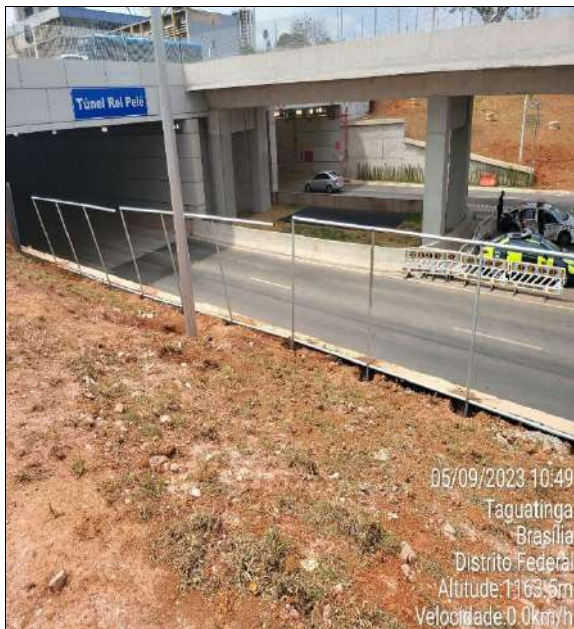
Serviço: Instalação de Alambrado Local: Taguatinga
