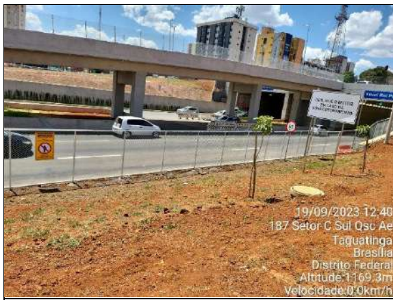
Serviço: Alambrado Finalizado Local: Taguatinga
