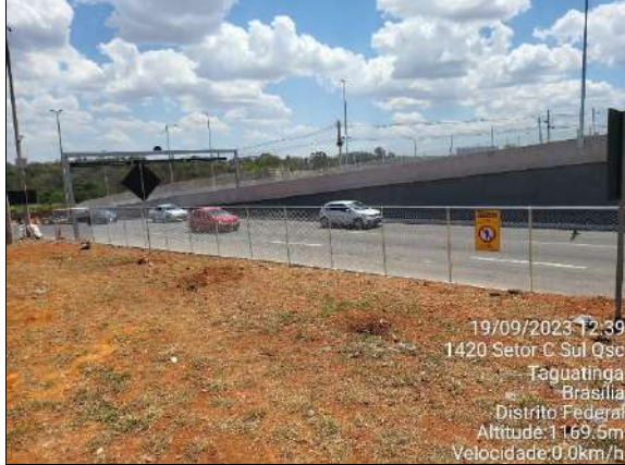
Serviço: Alambrado Finalizado Local: Taguatinga
