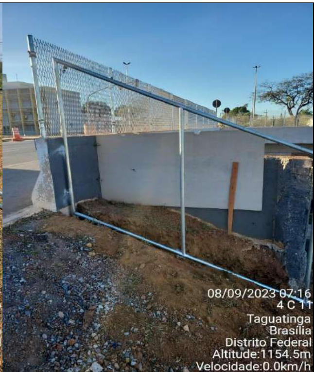
Serviço: Instalação de Alambrado Local: Taguatinga
