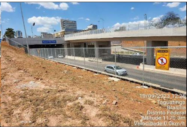
Serviço: Alambrado Finalizado Local: Taguatinga
