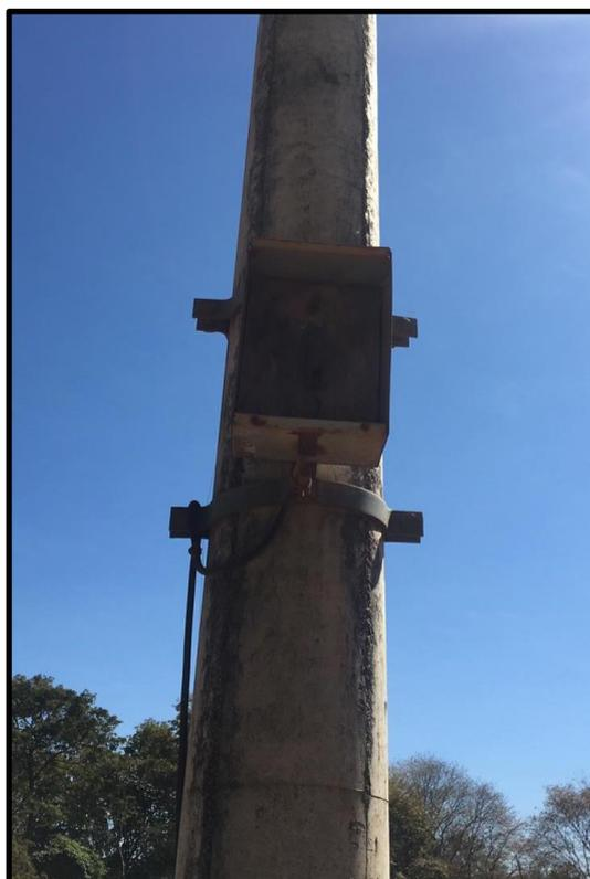
FOTO 04 – POSTES DE ILUMINAÇÃO CAIXA ELÉTRICA EXISTENTE DOS REFLETORES
