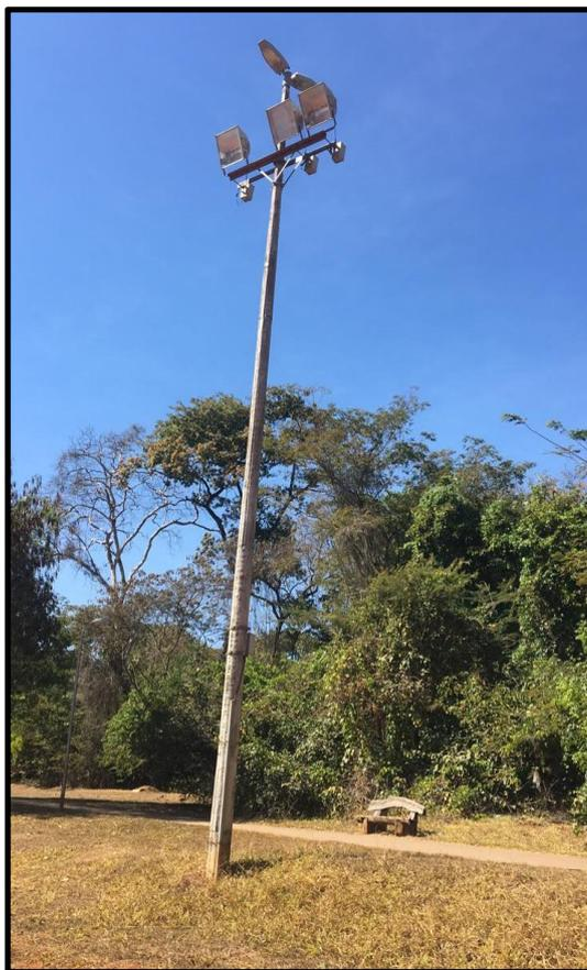
FOTO 03 – POSTES DE ILUMINAÇÃO EXISTENTES COM REFLETORES E LÂMPADAS DE VAPOR DE SÓDIO
